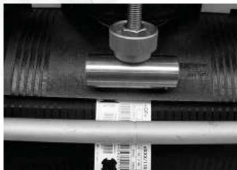
8. Zkontrolujte mezeru mezi sedlovou elektrotvarovkou a trubicou. Použijte k tomu svařovací kartu; hloubka zasunutí max. 1 cm; viz. značka „▶“ na svařovací kartě.
